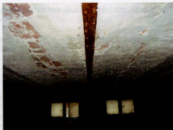
Kellerraum - Keller des Hauses Mitscherlichstr.34 - Schäden an der Kappe
