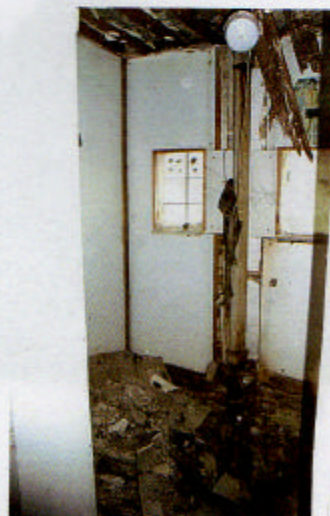
Abstellraum im Zwischengeschoss
