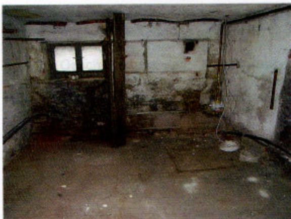
Kellerraum - Keller des Hauses Mitscherlichstr.34 - Schäden an der Kappe
